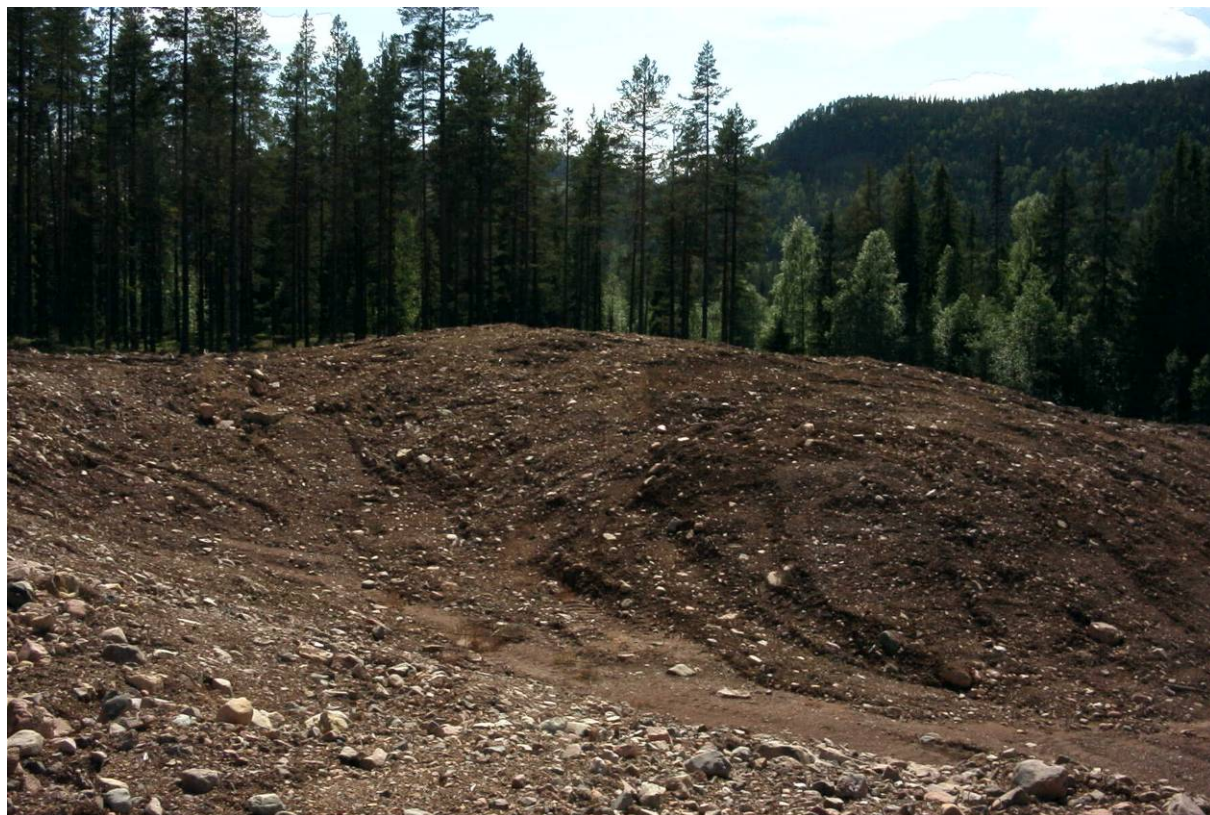
Moräntäkten släntades i samband med krossningen. Foto: Länsstyrelsen i Dalarnas län
