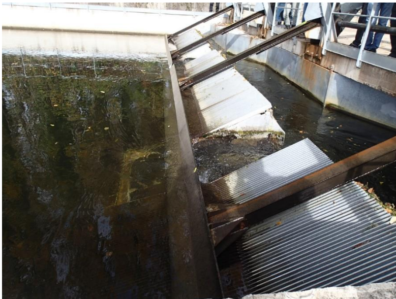
Figur 12 Låglutande galler med flyttöppningar för nedströmspassage, Frankrike. Foto: Länsstyrelsen i Västernorrlands län
