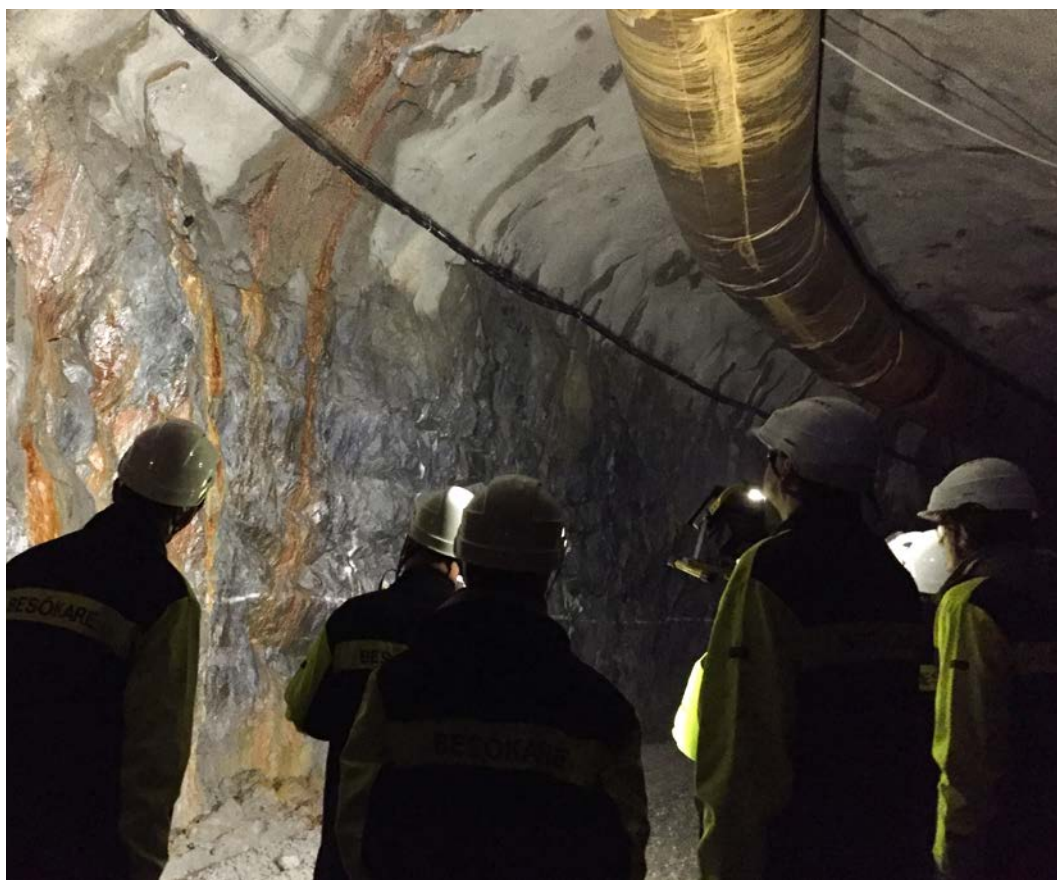
Underjordsförvar av kvicksilverhaltigt avfall. Fotograf: Länsstyrelsen i Västerbottens län.
